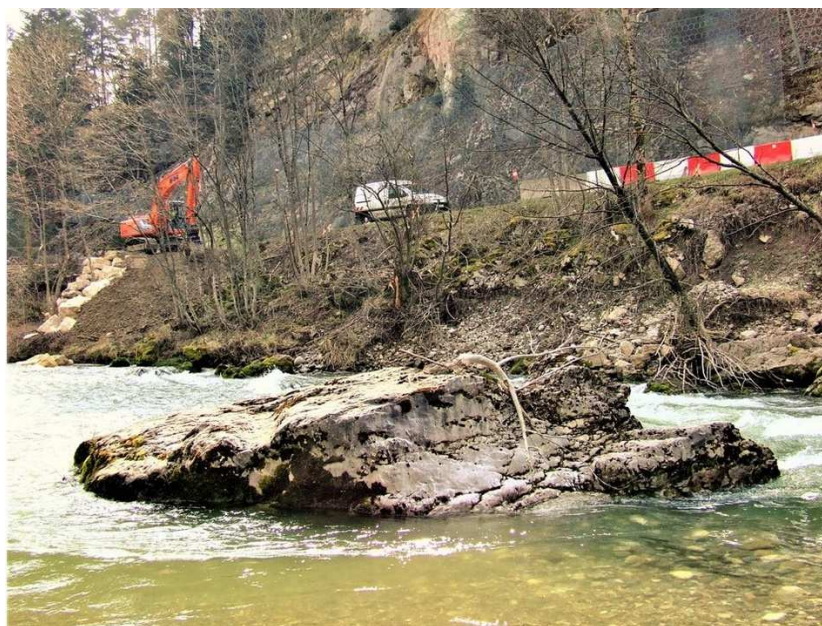
Photo n° 11 : Érosion de la base du talus
