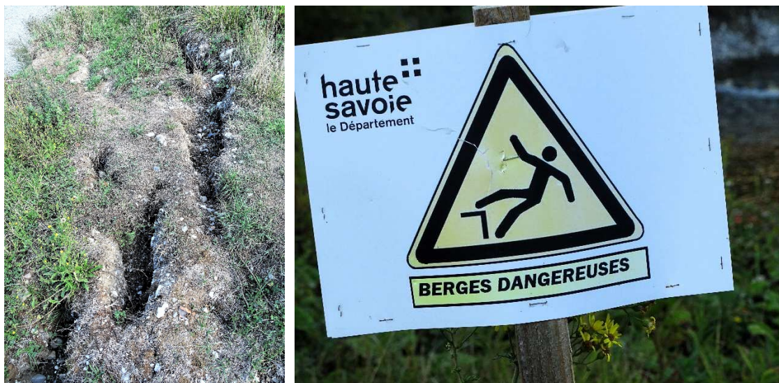
Photos n° 14a et 14b : Signalétique à l'abord des zones dangereuses
