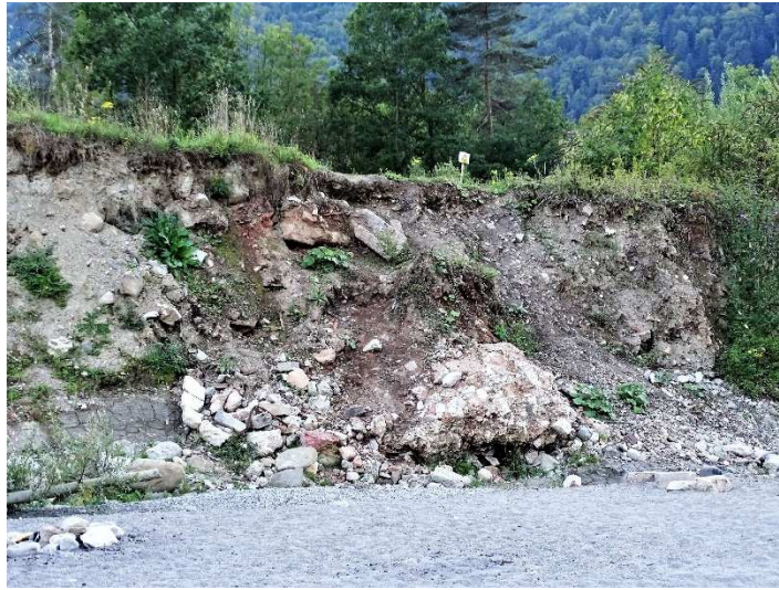
Photo n° 16 : Berge du Fier incluant des amas de débris
