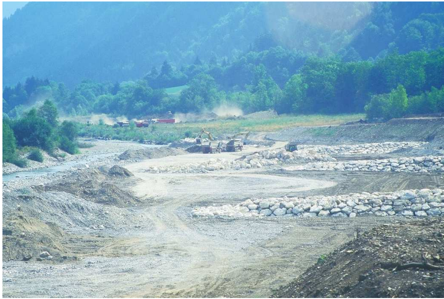
Photo n° 13 : Construction d'épis en enrochements à Alex
