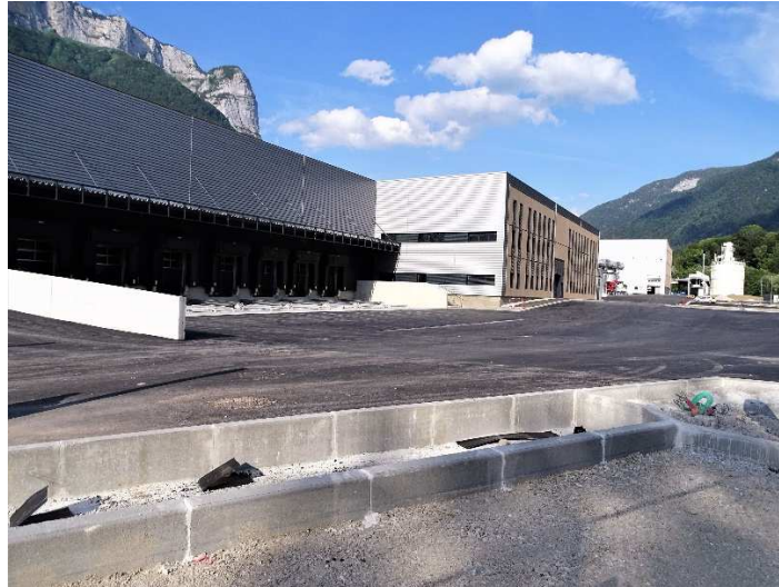
Photo n° 15 : Local industriel dans la zone d'activités de La Verrerie
